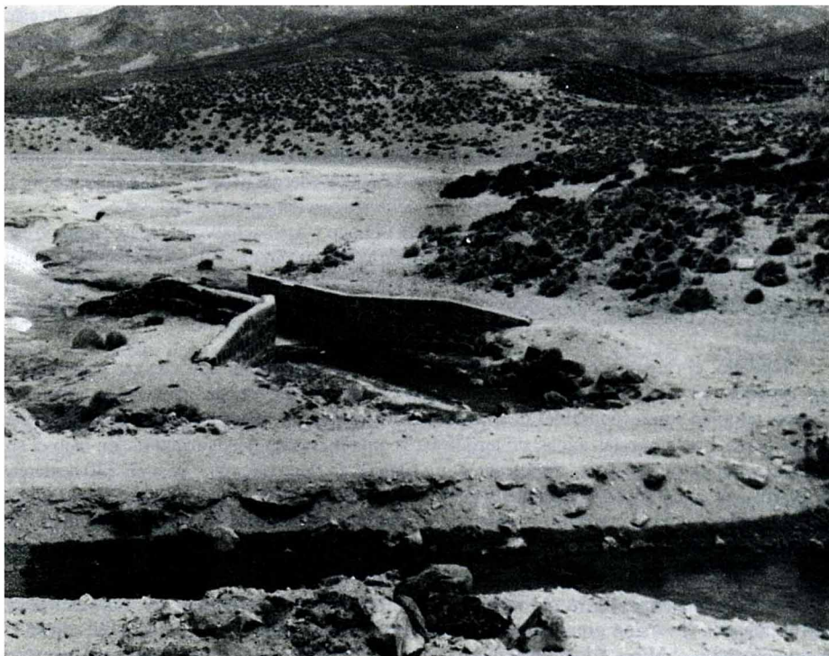
Figura 5. Esta excavación tosca, hecha en 1979 por la ENDESA, cortó 1,2 kilómetro del curso natural del río Lauca y secó una importante sección de bofedal de uso indígena. El bofedal, directamente al fondo del canal, queda disecado a pesar del verano húmedo de 1981.
