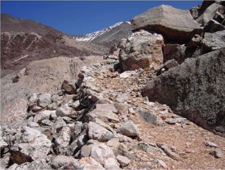
Figura 3. Muros de contención de un segmento de camino en el Nevado de Cachi.
