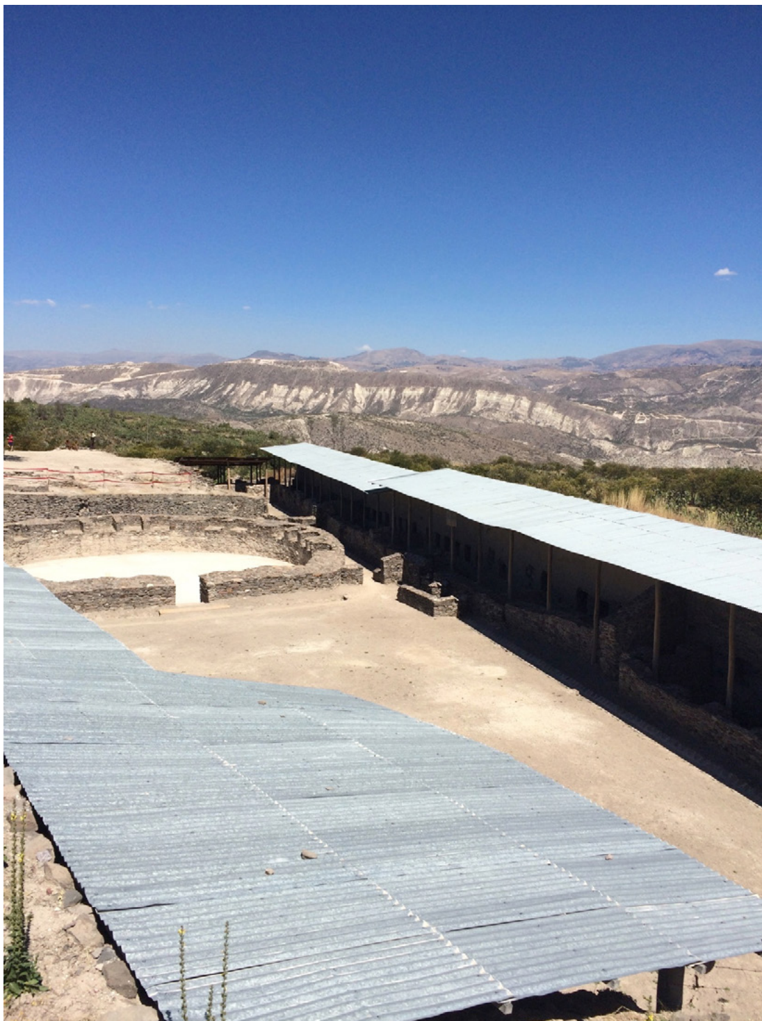
Figura 17. Techo de aluminio sobre la sección de Vegachayoq Moqo de Huari. Las imágenes de drones tomadas cuando se retiran los techos podrían agregarse a la plataforma digital.
