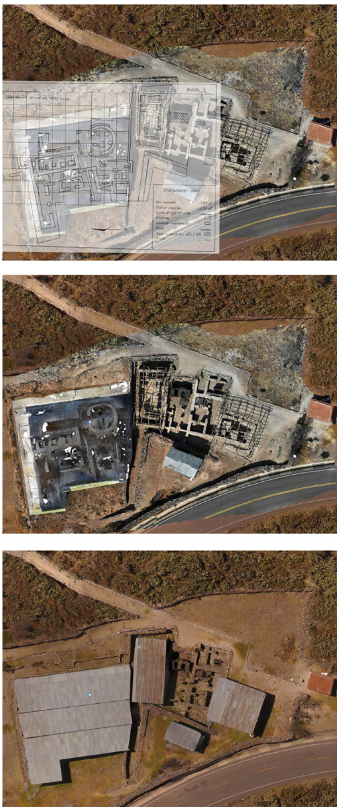
Figura 11. El uso de fotogrametría terrestre para “eliminar” los techos sobre Cheqo Huasi en Huari. De izquierda a derecha, techo como se encuentra in situ, ortomosaicos fotogramétricos de la arquitectura debajo y una superposición de dibujos de excavación originales para clarificar la organización espacial (Benavides 1991, Figura 2 ¿de Benavides?). The use of photogrammetry to “eliminate” the roofs on top of Cheqo Huasi in Huari. From left to right, the roof as it looks in situ, orthomosaic photographs of the architecture underneath, and the superposition of original excavation drawings to clarify spatial organization (after Benavides 1991, Figure 2).
